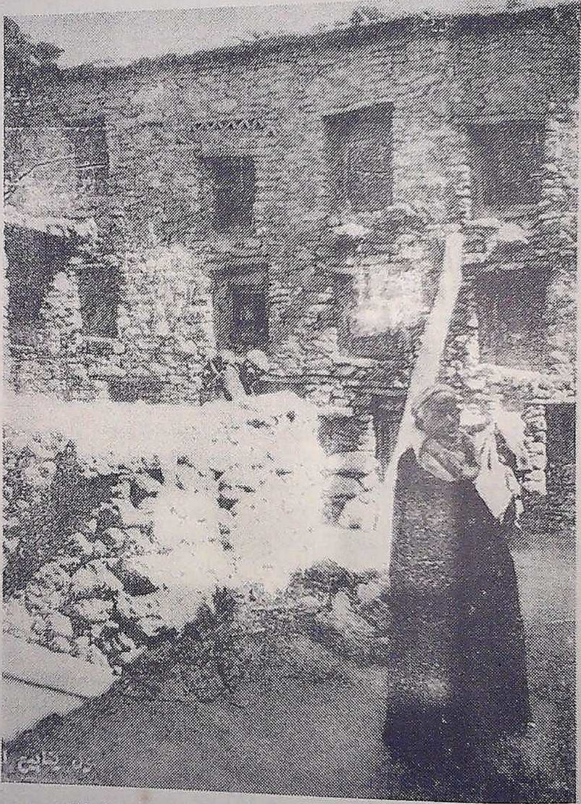
منظر داخلى لهرى عام فى تملوت ويوجد صهريج وسط الاجدير
